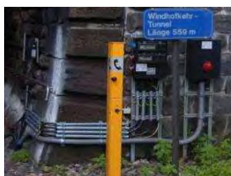
Notruffernsprecher am Portal
