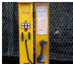
Notruffernsprecher geöffnet
